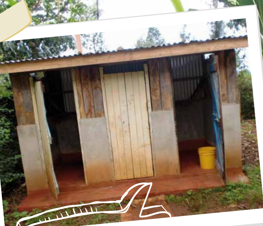
Die Duschen und in der Mitte das WC
